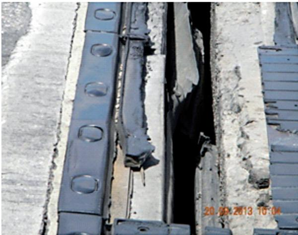
**Figura 4** – Destruição de junta de dilatação.
