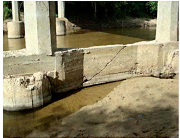
**Figura 7** – Ruptura da viga de amarração e grande excentricidade dos tubulões.
