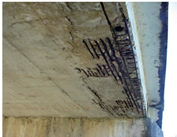
**Figura 3** – Destruição do concreto, com exposição e corrosão das armaduras dos tabuleiros em laje.
