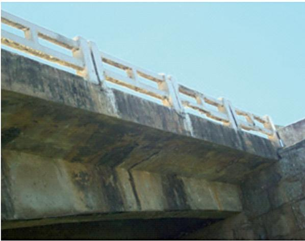
**Figura 10** – Infiltrações e eflorescências no tabuleiro, situação representativa de 69 das pontes analisadas.
