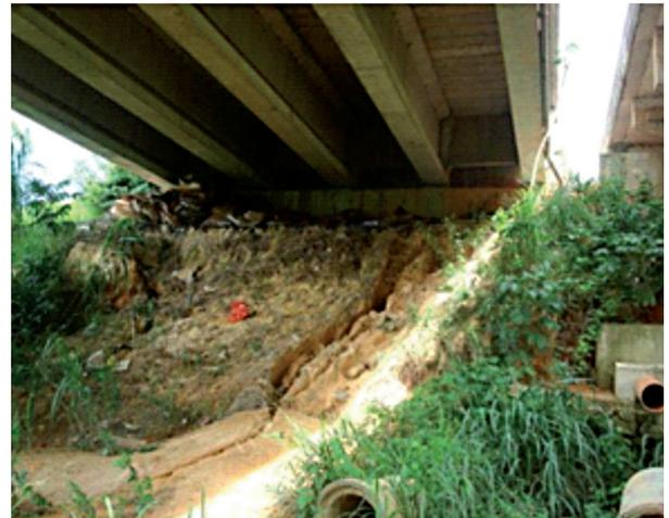
**Figura 8** – Erosão nos aterros dos encontros.
