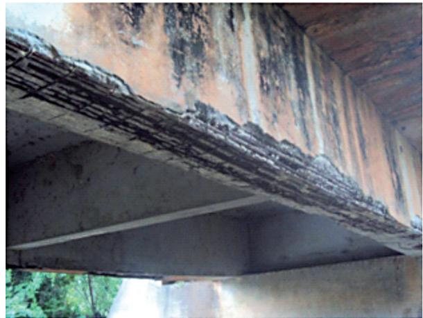
**Figura 2** – Grande deterioração estrutural do tabuleiro, com exposição e corrosão das armaduras das vigas.
