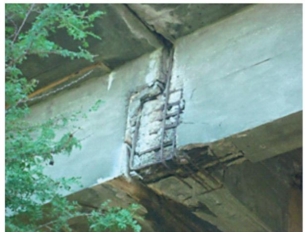
**Figura 9** – Dente Gerber com exposição de armaduras e avançado estado de degradação do concreto, com implicações de risco estrutural.
