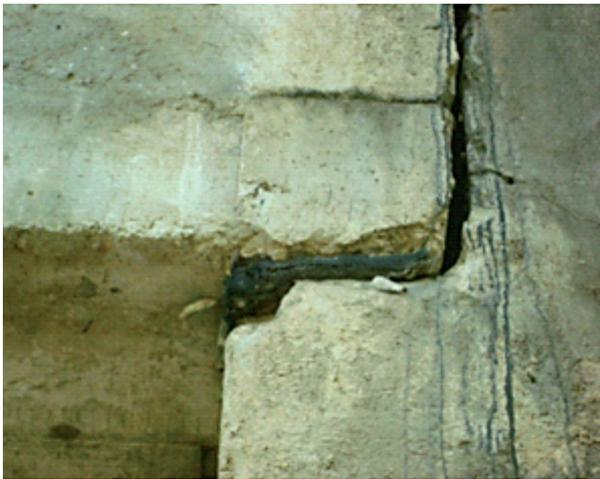
**Figura 5** – Avançado estado de deterioração dos aparelhos de apoio.
