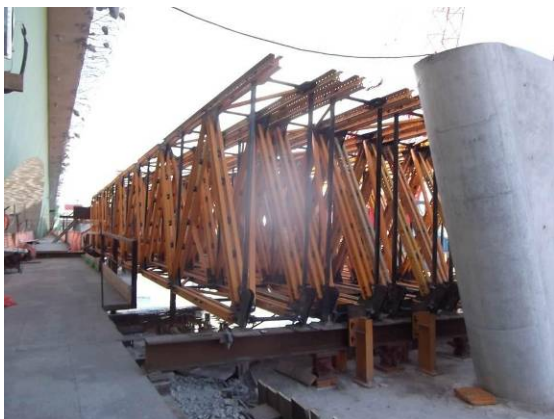
Figura 14 - Apoio do escoramento treliçado nos novos blocos de estacas.
