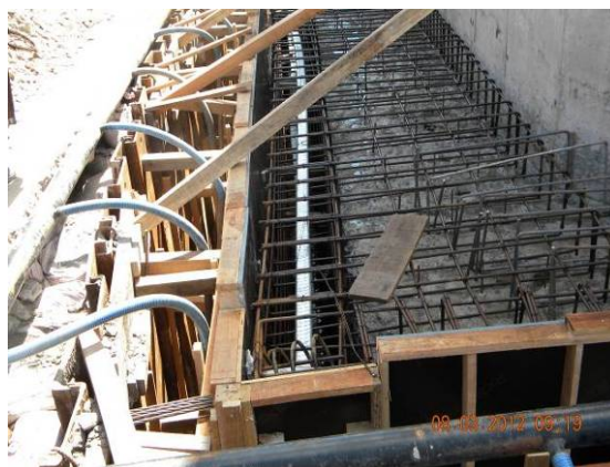
Figura 19 - Detalhe dos cabos de protensão.
