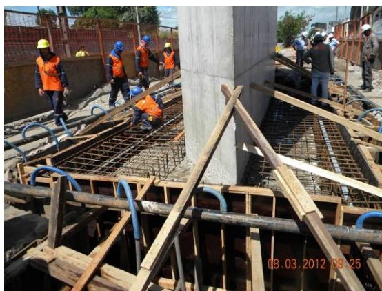
Figura 18 - Colocação das armaduras ativas e passivas do reforço.
