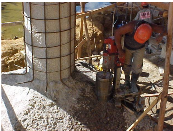
Figura 6 - Reforço dos pilares e execução das estacas.
