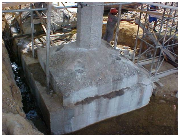
Figura 5 - Furos nas sapatas para a cravação das estacas.
