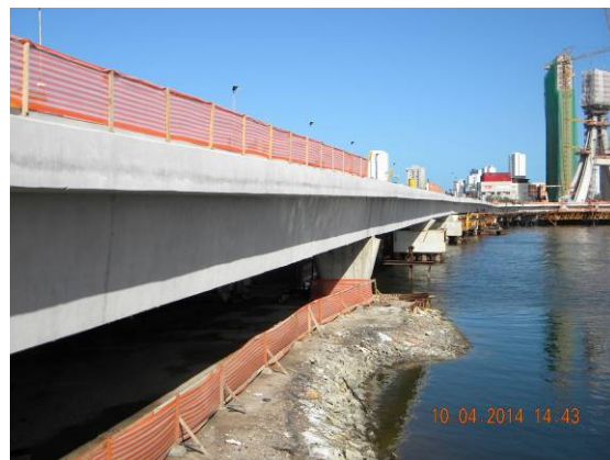
Figura 15 – Vista lateral da ponte alargada na fase dos acabamentos.
