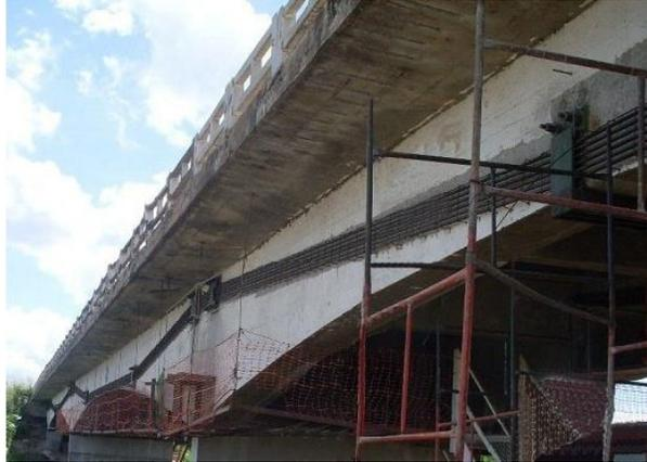
Figura 10 – Exemplo de reforço das longarinas de uma ponte com protensão externa (VITÓRIO. (2013)).
