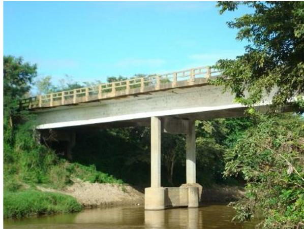
Figura 5 – Vista parcial da ponte antes do alargamento do tabuleiro (VITÓRIO. (2014)).
