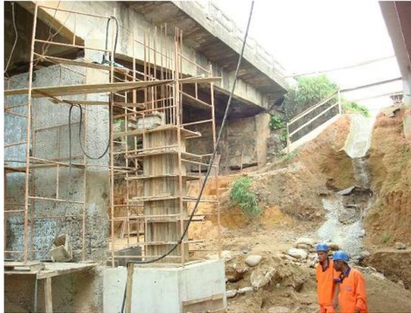
Figura 8 – Concretagem dos blocos e pilares adicionados a um dos apoios (VITÓRIO. (2014)).
