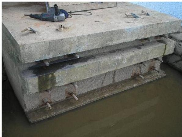
Figura 16 – Detalhe do bloco após o reforço (VITÓRIO. (2013)).
