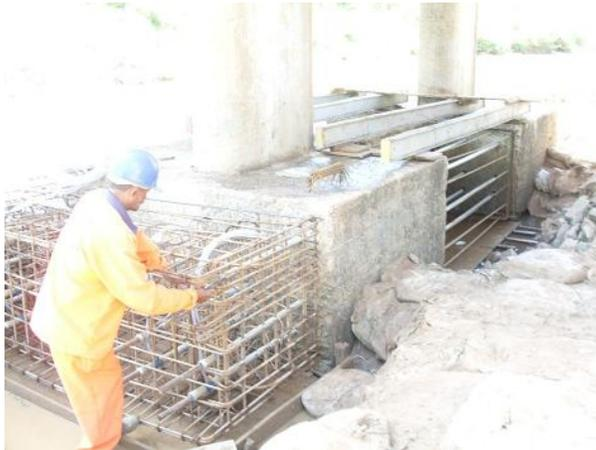
Figura 15 – Execução de reforço em fundação de ponte com cravação de estacas adicionais e aplicação de protensão no bloco (VITÓRIO. (2013)).
