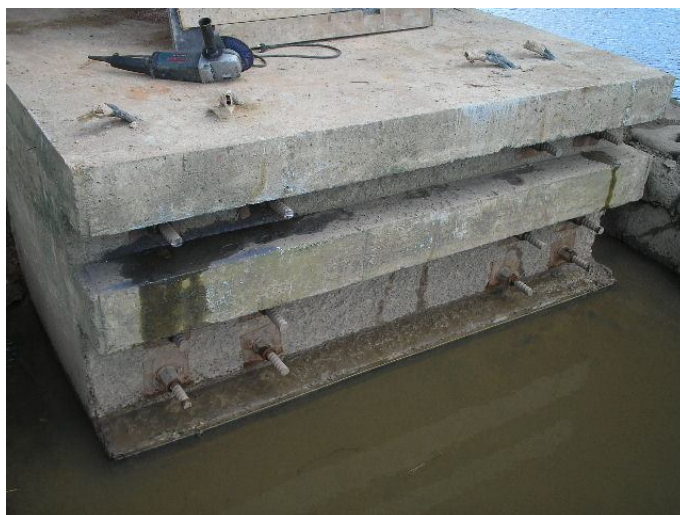
Figura 31 - Reforço do bloco após a realização da concretagem. (Ponte na BR 101/PE).
