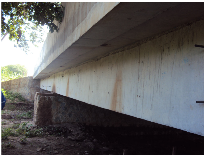
Figura 67 - Vista lateral após a conclusão da obra de alargamento e reforço. (Ponte sobre o rio Tamanduá - BR-116/CE).
