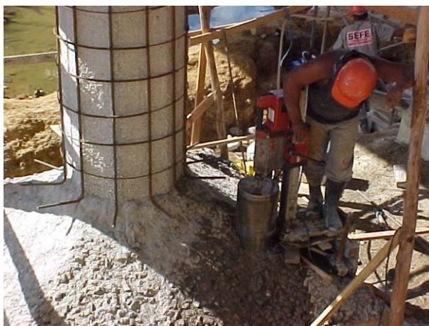
Figura 24 - Reforço dos pilares e cravação das estacas. (Ponte sobre o Riacho Ingazeiro - PE-057).
