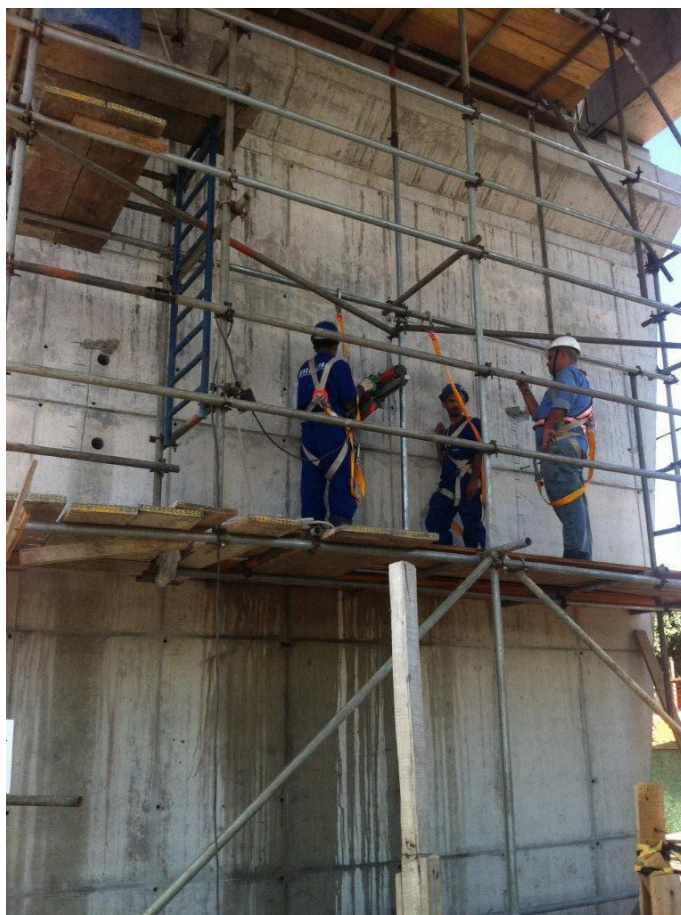
Figura 40 - Extração dos testemunhos do pilar. (Viaduto Capitão Temudo).
