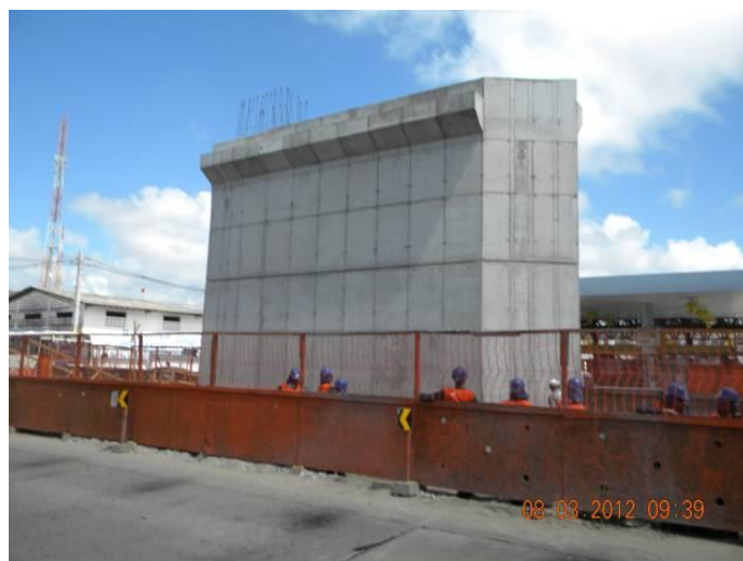
Figura 49 - Posicionamento do pilar e do bloco no canteiro estreito entre duas pistas. (Viaduto Capitão Temudo).
