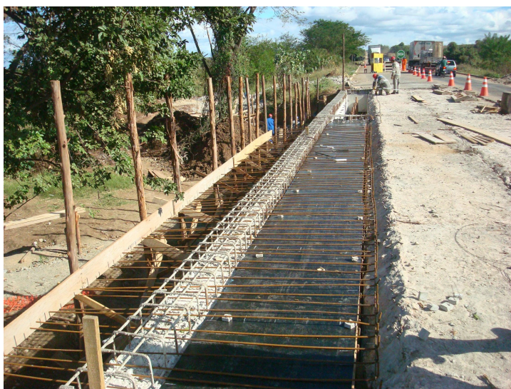
Figura 66 - Vista superior do alargamento do tabuleiro. (Ponte sobre o rio Tamanduá - BR-116/CE).
