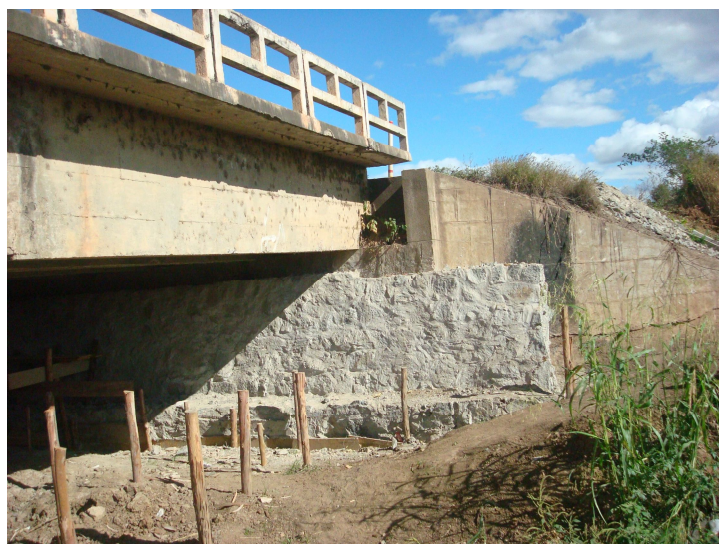
Figura 63 - Execução do reforço dos encontros com alvenaria de pedras (Ponte sobre o rio Tamandú - BR-116/CE).
