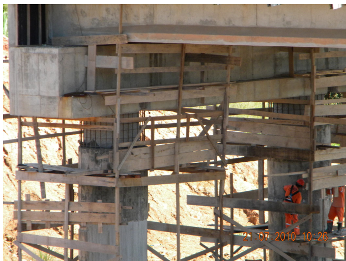
Figura 33 - Etapa final do reforço dos pilares do viaduto. (TDR-Norte - Suape).
