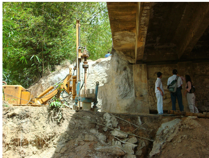
Figura 4 - Execução de estacas raiz para reforço dos encontros (Ponte sobre o rio Botafogo - BR 101/PE).
