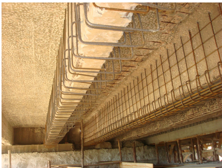
Figura 64 - Vista do reforço do encontro e das vigas do tabuleiro, também reforçadas. (Ponte sobre o rio Tamanduá - BR/116/CE).
