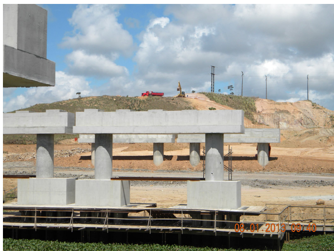
Figura 38 - Vista geral das fundações e mesoestrutura. (Ponte sobre o rio Pirapama - Suape).
