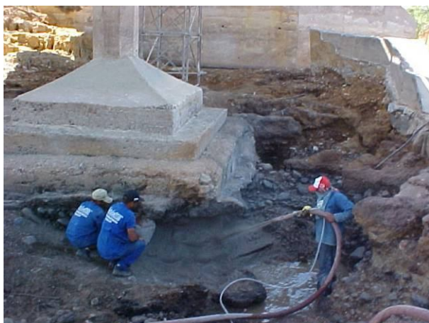
Figura 22 - Consolidação da base da sapata com argamassa projetada. (Ponte sobre o Riacho Ingazeiro - PE-057).
