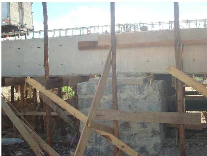
Figura 65 - Reforço do pilar-parede central. (Ponte sobre o rio Tamanduá - BR-116/CE).
