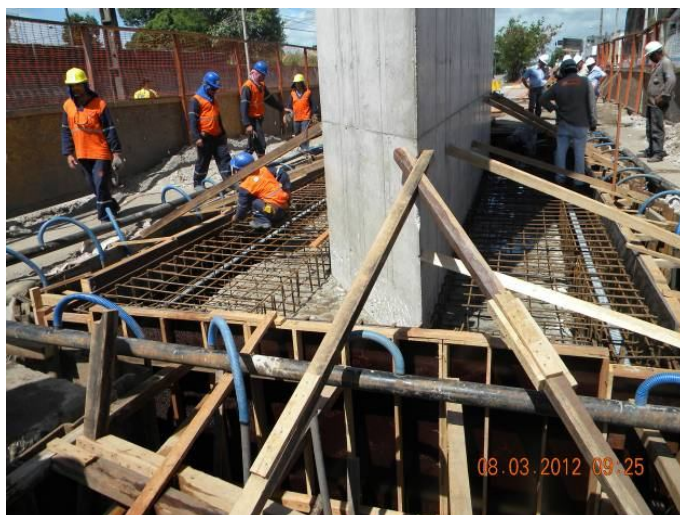
Figura 45 - Colocação das armaduras ativas e passivas do reforço. (Viaduto Capitão Temudo).
