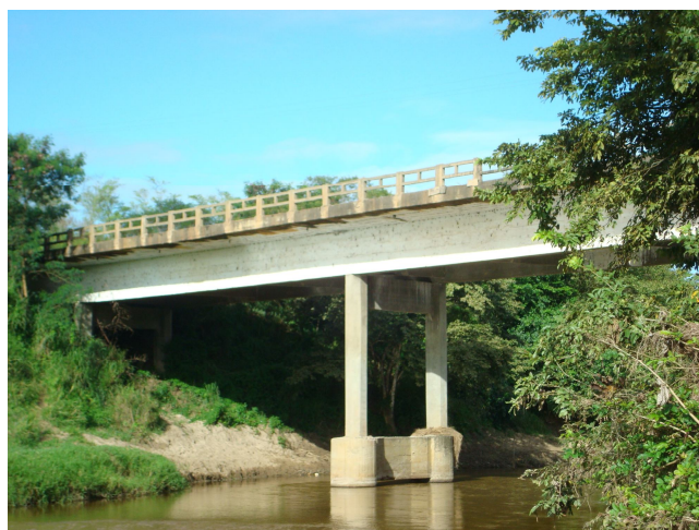
Figura 1- Parte da vista longitudinal da ponte antes do alargamento (Ponte sobre o rio Itiúba - BR 101/AL).
