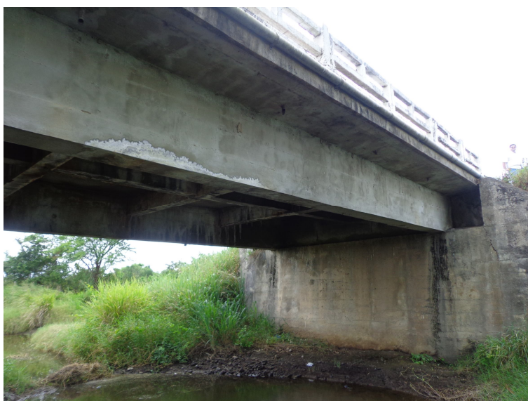
Figura 68 - Vista lateral da ponte original (Ponte sobre o rio Patu - BR-230/PB).
