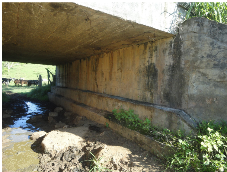
Figura 57 - Vista dos encontros de concreto ciclópico (Ponte na RJ-158).
