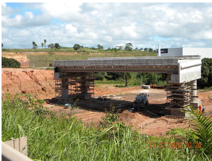
Figura 32 - Execução de reforço nos pilares do viaduto (TDR-Norte - Suape).
