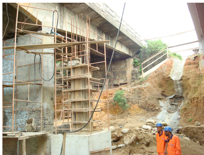
Figura 5 - Blocos e pilares adicionados ao apoio central durante a concretagem. (Ponte sobre o rio Botafogo - BR 101/PE).
