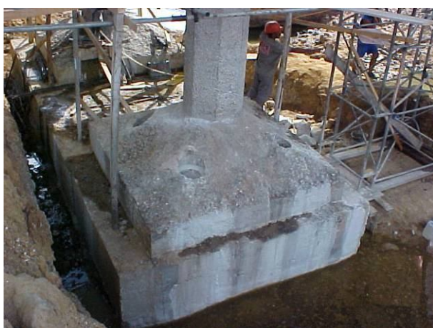
Figura 23 - Furos nas sapatas para a cravação das estacas. (Ponte sobre o Riacho Ingazeiro - PE-057).
