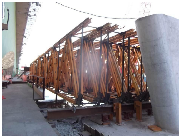
Figura 9 - Apoio das treliças nos blocos de estacas. (Ponte Paulo Guerra).
