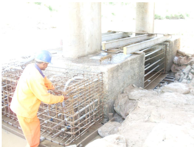
Figura 30 Execução do reforço de bloco de fundação de uma ponte com a utilização de protensão. (Ponte na BR 101/PE).
