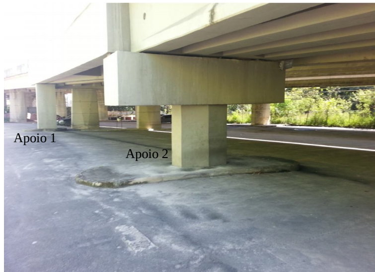
Figura 52 - Vista dos apoios 1 e 2. (Alça de acesso ao Carrefour).
