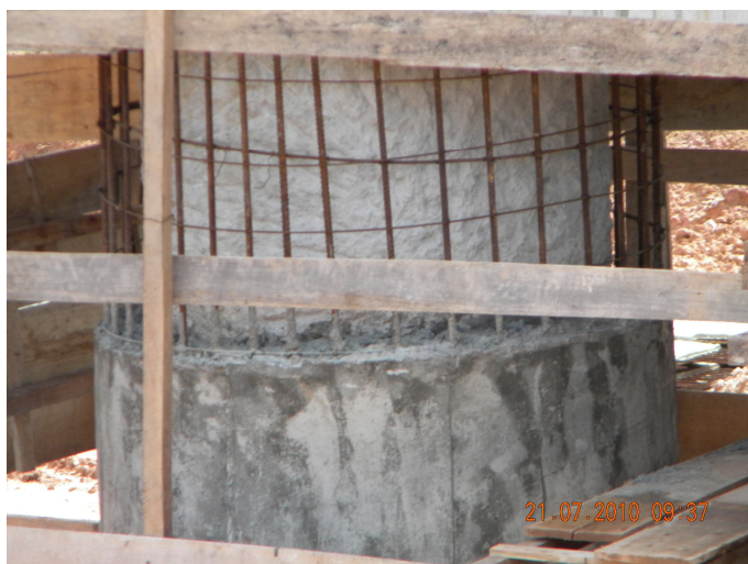
Figura 34 - Detalhe do reforço do pilar. (TDR-Norte - Suape).
