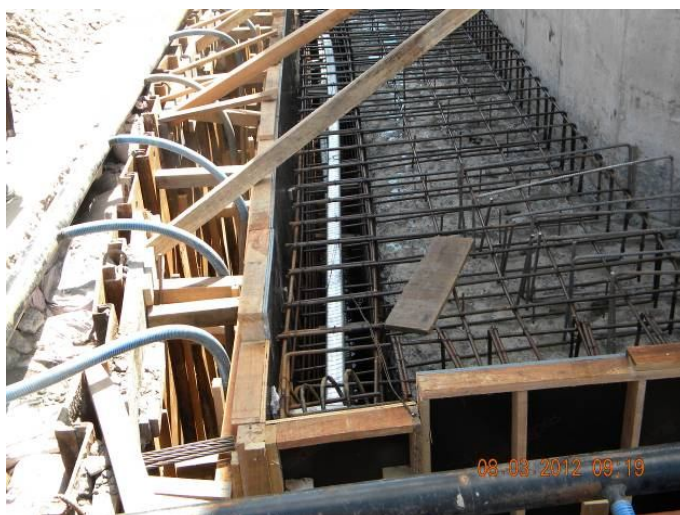
Figura 46 - Detalhe dos cabos de protensão. (Viaduto Capitão Temudo).
