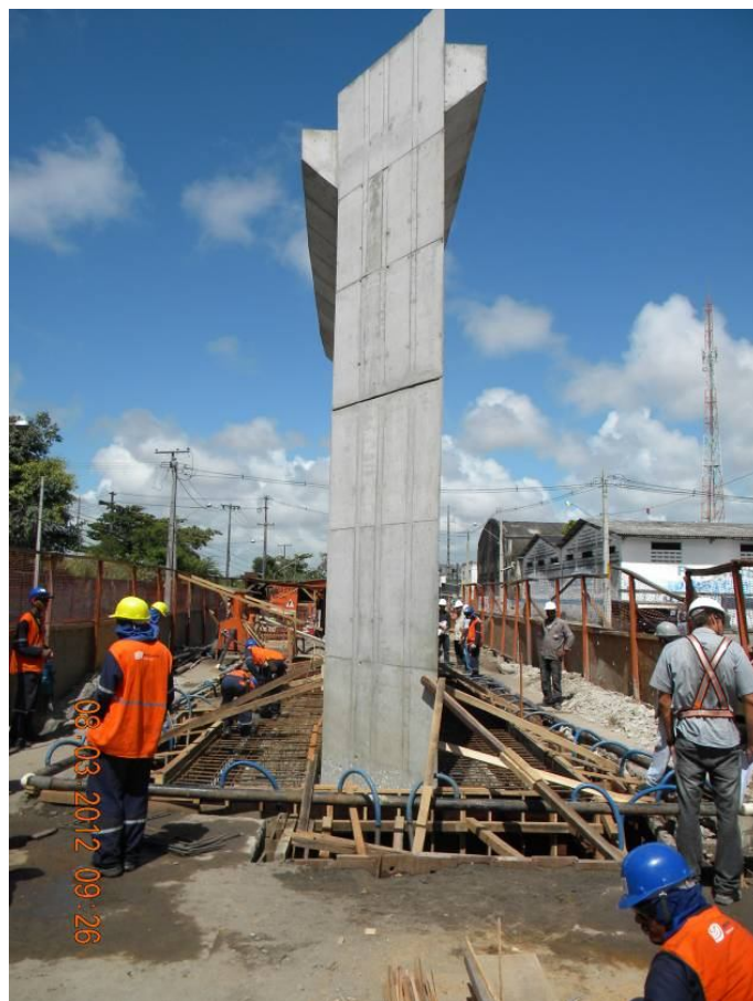
Figura 48 - Vista geral do pilar e do bloco. (Viaduto Capitão Temudo).
