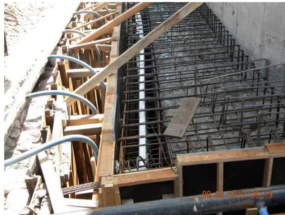
**Figura 19 – Detalhe dos cabos de protensão.**
