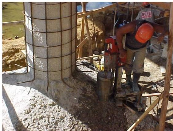
**Figura 10 – Reforço dos pilares e cravação das estacas.**
