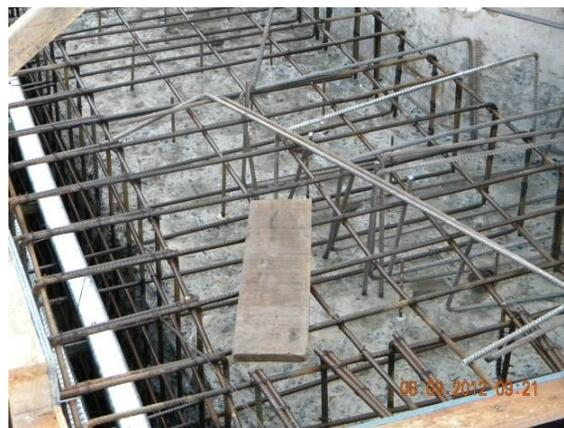
**Figura 20 – Detalhe das armaduras passivas e dos conectores de aderência.**
