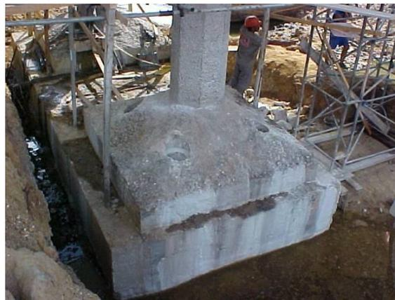
**Figura 9 – Furos nas sapatas para a cravação das estacas.**
