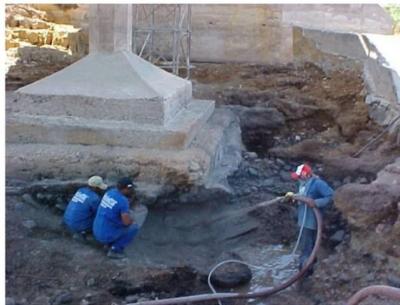
**Figura 8 – Consolidação da base da sapata com argamassa projetada.**
