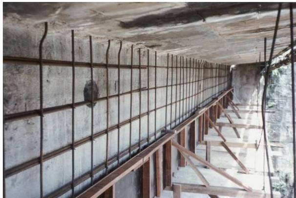
Figura 3.5 - Posicionamento da forma para a concretagem convencional do talão de reforço da viga principal. (Fonte: VITÓRIO, 2007)
