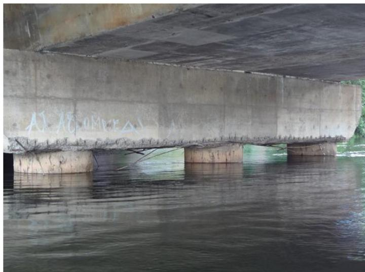
Figura 5.13 – Armaduras expostas e seccionadas nas travessas da ponte do Derby (Fonte: SILVA, 2014).
