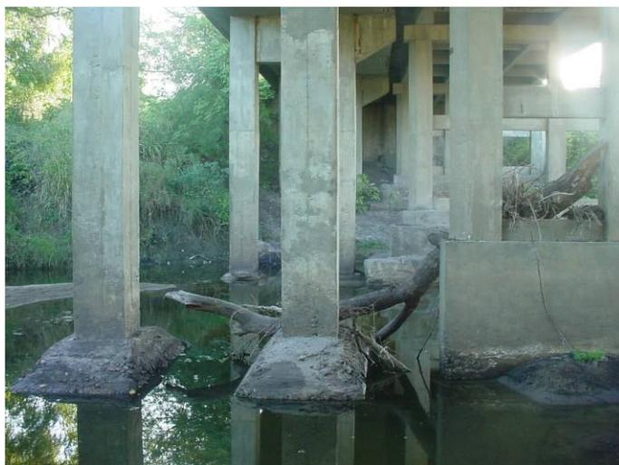
Figura 2.9 – Retenção de sólidos e ocorrência de erosões e descalçamento das fundações. (Fonte: VITÓRIO, 2008).
