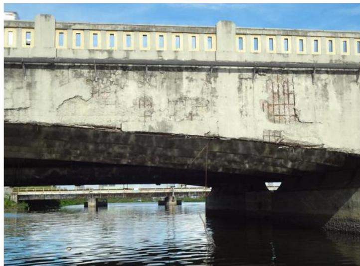
Figura 5.11 – Grande deterioração das vigas de bordo na ponte Motocolombó (Fonte: SILVA, 2014).
