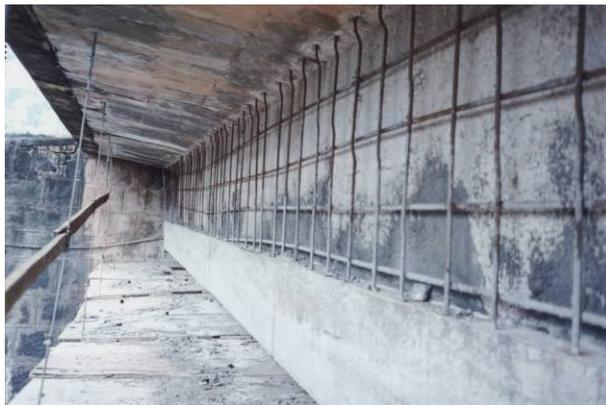
Figura 3.6 - Talão de reforço após a concretagem. (Fonte: VITÓRIO, 2007)
