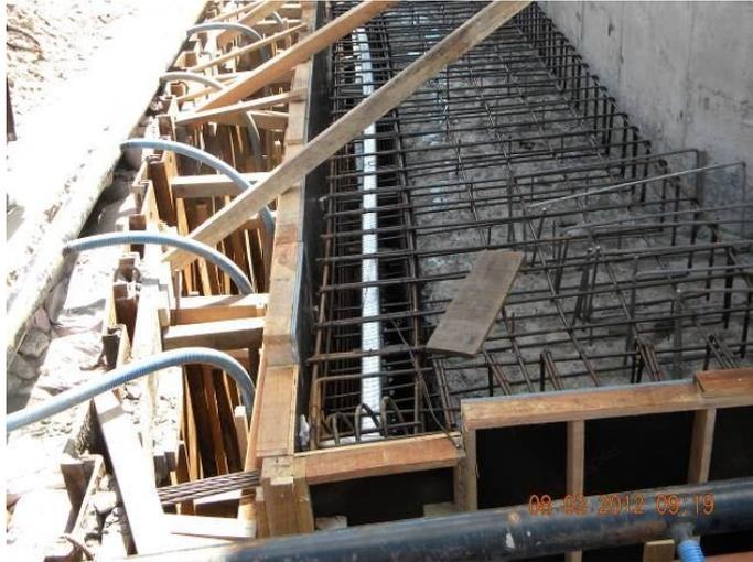
Figura 3.36 - Detalhe dos cabos de protensão. (Fonte: VITÓRIO, 2014)
