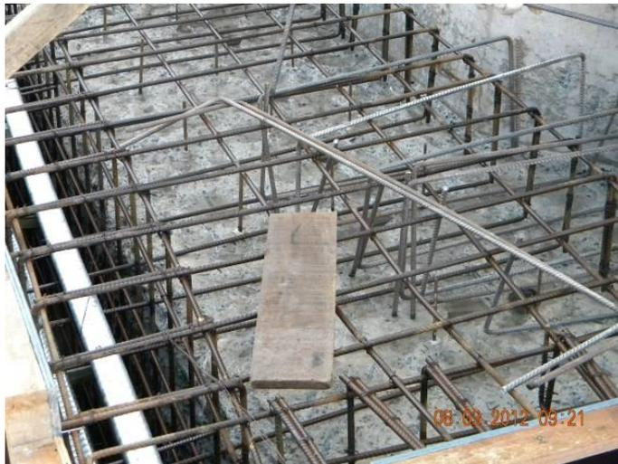
Figura 3.37 - Detalhe das armaduras passivas e dos conectores de aderência. (Fonte: VITÓRIO, 2014)
