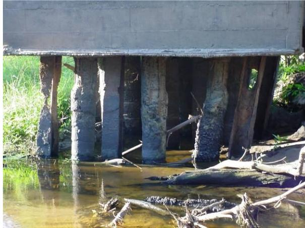
Figura 3.26 - Detalhe da deterioração e perda de seção transversal das estacas.
