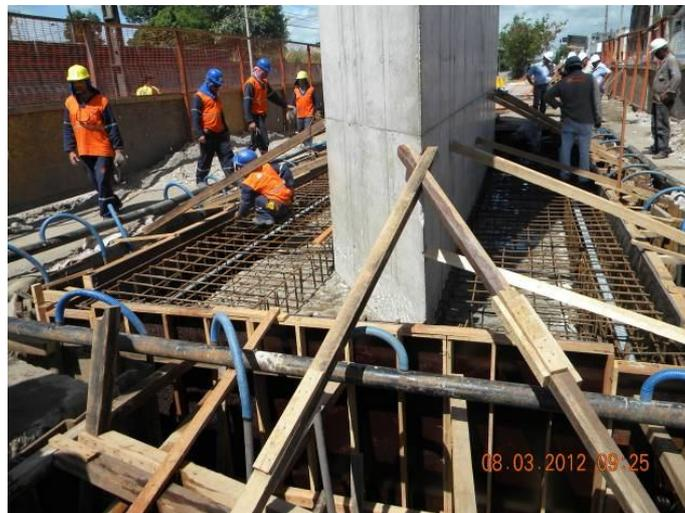
Figura 3.35 - Colocação das armaduras ativas e passivas do reforço. (Fonte: VITÓRIO, 2014)
