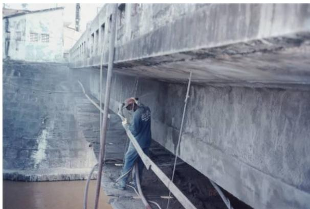
Figura 3.7 - Aplicação de concreto projetado na face lateral da viga principal. (Fonte: VITÓRIO, 2007)
