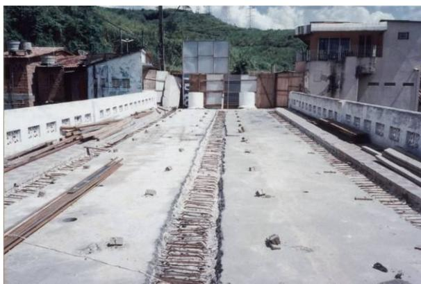
Figura 3.8 - Vista superior do lastro, mostrando a concretagem convencional da sobrelaje as armaduras transversais das vigas. (Fonte: VITÓRIO, 2007)
