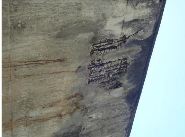
Figura 5.12 – Ausência de pingadeira, deslocamento do concreto e corrosão das armaduras, caracterizando uma situação típica do tabuleiro do Viaduto das Cinco Pontas (Fonte: SILVA, 2014).
