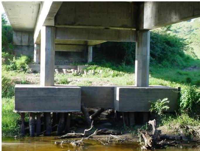
Figura 3.25 - Estacas expostas e desconfinadas por causa do rebaixamento do leito do rio. (Fonte: VITÓRIO e BARROS, 2012)
