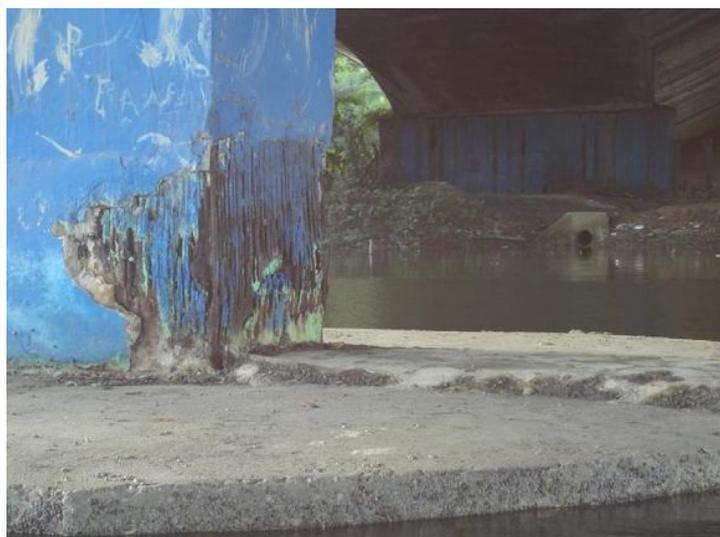
Figura 5.14 – Lixiviação do bloco de fundação e avançado estado de corrosão nas armaduras de pilar da ponte Papa João Paulo II (Fonte: SILVA, 2014).
