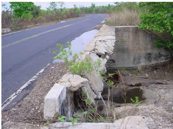
Figura 2.10 – Vista superior mostrando a destruição dos guarda-corpos, empoçamento de água sobre o tabuleiro. (Fonte: VITÓRIO, 2008).
