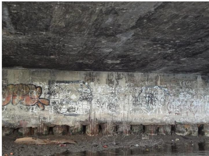
Figura 5.10 – Estacas e encontros com armaduras corroídas, deslocamento do concreto e lixiviação generalizada na ponte da Capunga (Fonte: SILVA, 2014).
