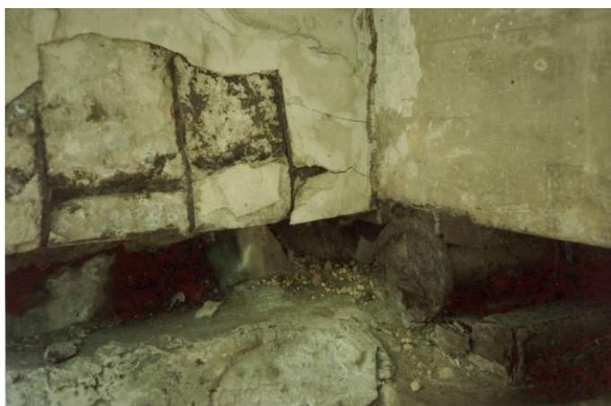
Figura 2.6 – Destruição do concreto e armaduras além do travamento dos aparelhos de apoio. (Fonte: VITÓRIO, 2008).
