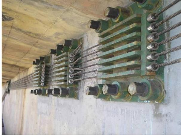
Figura 3.12 – Dispositivos metálicos utilizados para a ancoragem das cordoalhas nas extremidades da viga. (Fonte: VITÓRIO, 2013)
