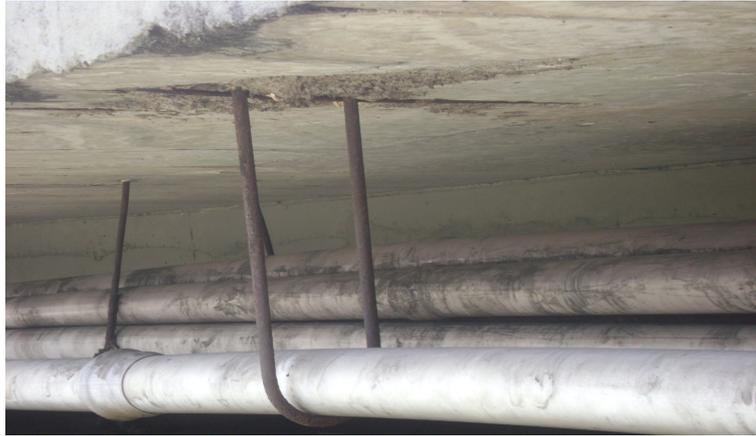
Figura 5.4 – Uma situação muito comum de fixação inadequada em ponte sobre o Canal de Setubal, evidenciando-se os danos causados à laje do tabuleiro pelos furos de ancoragem dos tirantes (Fonte: NETO, 2008).
