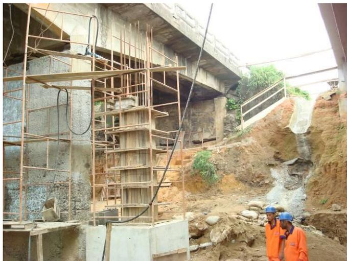
Figura 3.23 - Blocos e pilares adicionados ao apoio central durante a concretagem. (Fonte: VITÓRIO, 2014)
