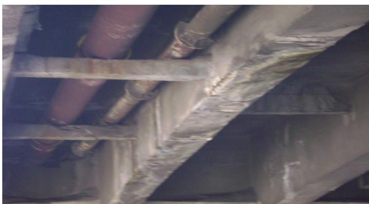
Figura 5.2 – Na Ponte Princesa Isabel o suporte de concreto encontra-se em estado de ruína, devido ao vazamento da tubulação que não apresenta mais condição de operação (Fonte: NETO, 2008).
