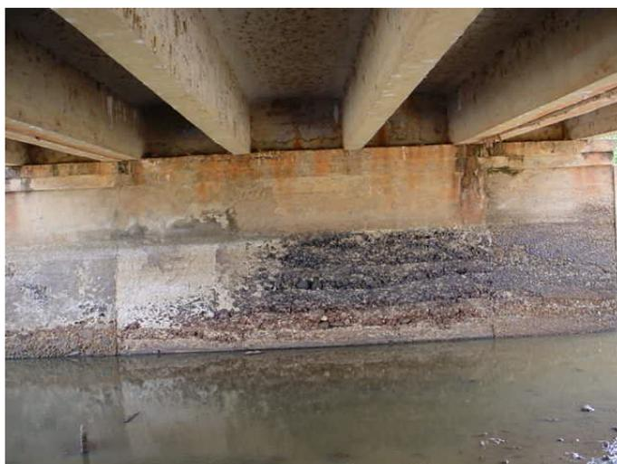
Figura 2.5 – Fissuras verticais dos dois lados, nas partes onde a ponte foi alargada, e a grande intensidade de lixiviação do concreto. (Fonte: VITÓRIO, 2008).
