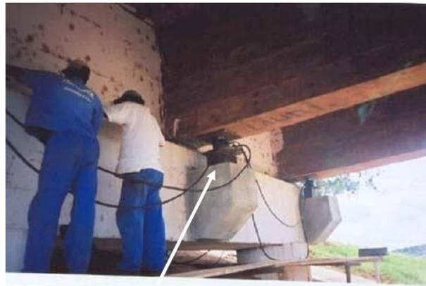
Figura 4.5 - Macacos hidráulicos apoiados sobre consolas para substituição dos aparelhos de apoio.
