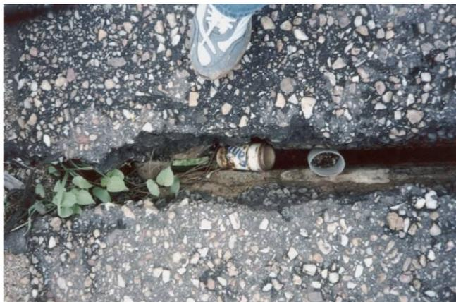
Figura 2.4 – Abertura excessiva da junta de dilatação do tabuleiro, causando infiltração e desconforto ao tráfego. (Fonte: VITÓRIO, 2008).
