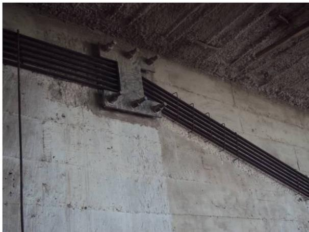
Figura 3.14 – Detalhe de um desviador metálico das cordoalhas na parte superior da viga (no apoio). (Fonte: VITÓRIO, 2013)
