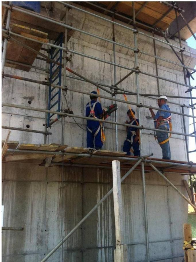
Figura 3.30 - Extração dos testemunhos do pilar. (Fonte: VITÓRIO, 2014)
