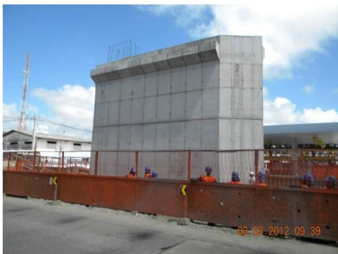
Figura 3.39- Posicionamento do pilar e do bloco no canteiro estreito entre duas pistas. (Fonte: VITÓRIO, 2014)
