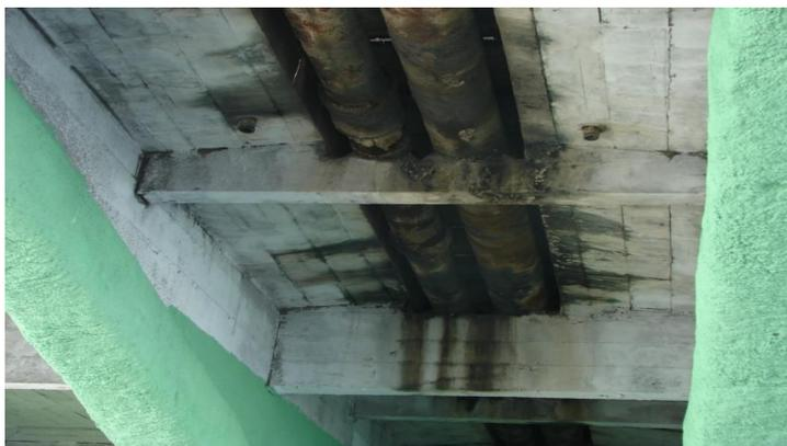
Figura 5.1 – Avançado estado de deterioração estrutural na ponte Engº Antônio de Goes sobre o rio Capibaribe, causado pelo vazamento das adutoras (Fonte: NETO, 2008).
