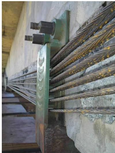
Figura 3.13 – Detalhe de um desviador metálico das cordoalhas na parte inferior da viga (no vão). (Fonte: VITÓRIO, 2013)
