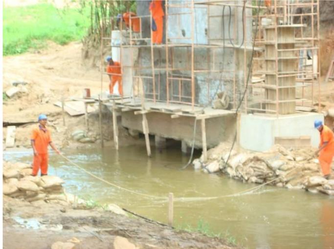
Figura 3.24 - Fundações existentes e fundações adicionais do apoio central. (Fonte: VITÓRIO, 2014)
