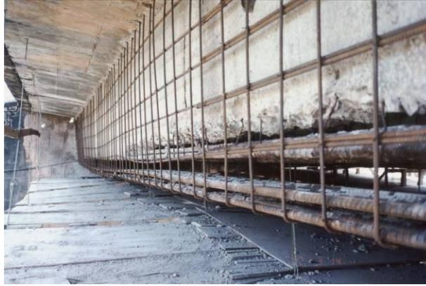
Figura 3.4 - Posicionamento dos ferros longitudinais, estribos e armadura de pele de reforço das vigas principais. (Fonte: VITÓRIO, 2007)
