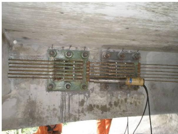
Figura 3.15 – Aplicação da protensão em cada cordoalha. (Fonte: VITÓRIO, 2013)
