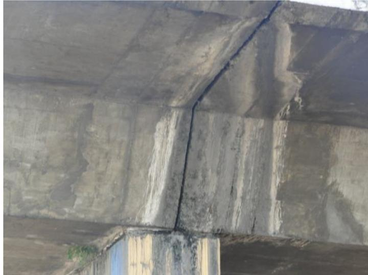
Figura 5.7 – Situação típica de danos causados à estrutura por infiltrações nas juntas de dilatação pode ser observada no Viaduto da BR-101 sobre a Av. Caxangá (Fonte: XIMENES, 2010).
