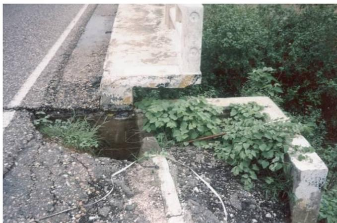
Figura 2.11 – Erosão no aterro de acesso na ligação ponte/rodovia. (Fonte: VITÓRIO, 2008).
