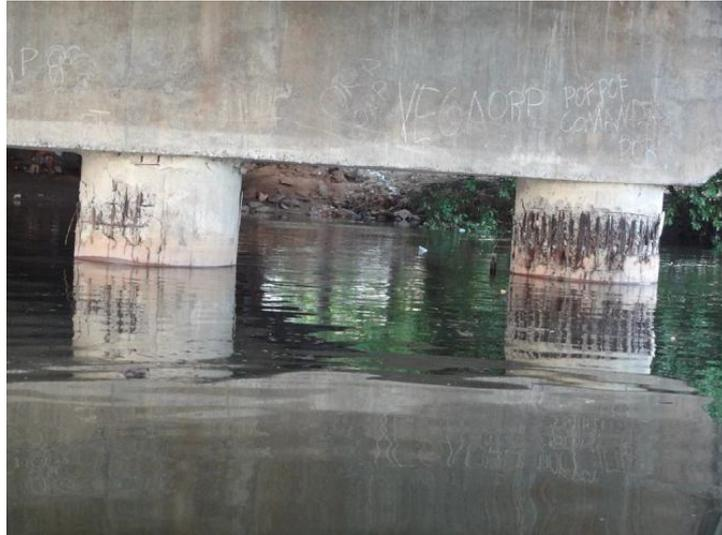
Figura 5.9 – Estado avançado de corrosão dos pilares / tubulões, na ponte da Torre (Fonte: SILVA, 2014).
