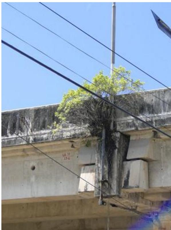
Figura 5.5 – Lixiviação do concreto e aparecimento de vegetação na estrutura do Viaduto Tancredo Neves, causadas pela falta de conservação das juntas dos dentes Gerber (Fonte: XIMENES, 2010).
