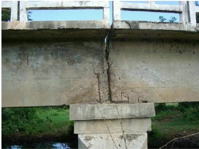
Figura 2.3 – Abertura excessiva da junta do tabuleiro, esmagamento do concreto nos apoios e patologias diversas nas vigas principais. (Fonte: VITÓRIO, 2008).
