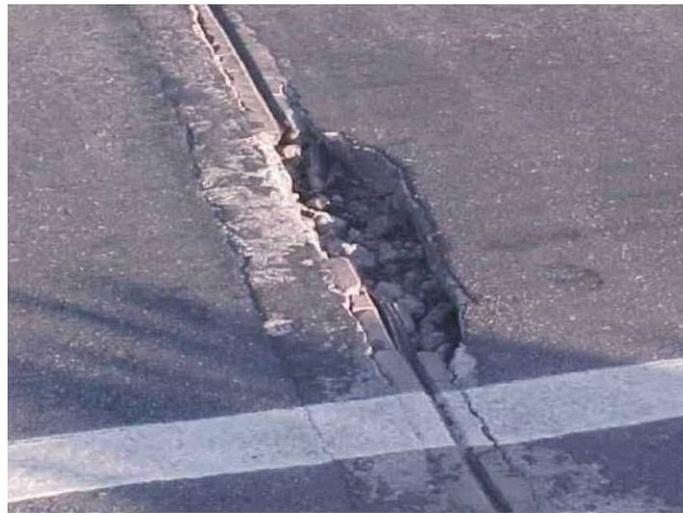
Figura 4.8 – Destruição parcial de uma junta de dilatação. (Fonte: VITÓRIO, 2008)
