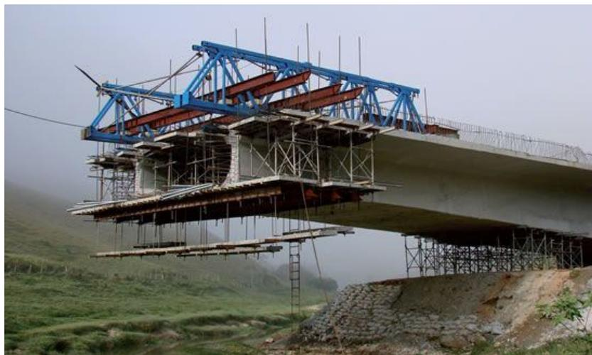
Figura 1.13 – Execução de balanços sucessivos com aduelas moldadas no local (Fonte: Revista Infraestrutura, Ed. 21, 2012).
