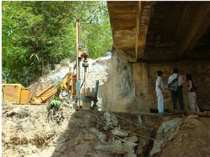
Figura 3.22 - Execução de estacas raiz para reforço dos encontros. (Fonte: VITÓRIO, 2014)
