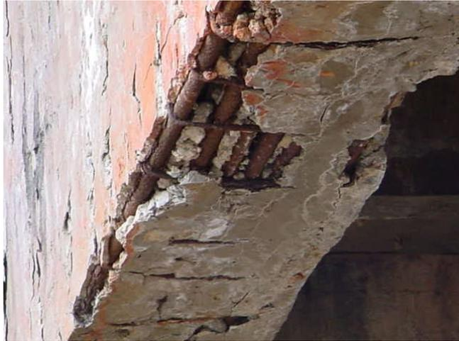
Figura 2.2 – Detalhe do avançado grau de deterioração do concreto e oxidação das armaduras das vigas principais. (Fonte: VITÓRIO, 2008).
