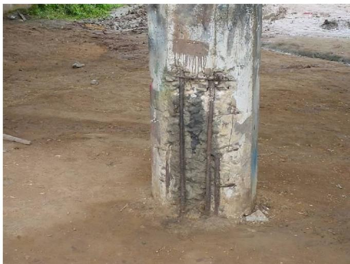
Figura 2.7 – Pilar com deslocamento do concreto, corrosão das armaduras e destruição dos estribos na parte inferior. (Fonte: VITÓRIO, 2008).
