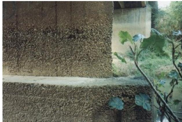
Foto 4.3.5.5 – efeito da lixiviação no concreto do pilar e bloco de estacas, causado, provavelmente, pela presença de agentes agressivos na água do rio.
