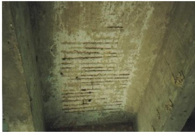
Foto 4.3.3 – **avarias em lajes centrais do tabuleiro** – laje em avançado estado de deterioração, com armadura positiva exposta e oxidada. Tais problemas são geralmente causados pela má impermeabilização do tabuleiro associada à porosidade do concreto e meio ambiente agressivo.
