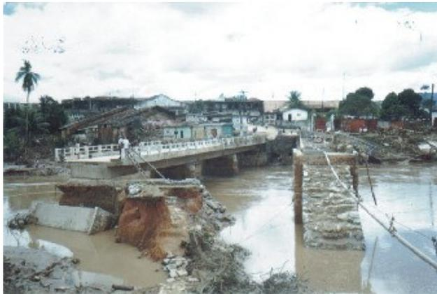
Foto 4.3.5.8 – destruição dos aterros das cabeceiras de uma ponte provocada por uma grande enchente no rio.
