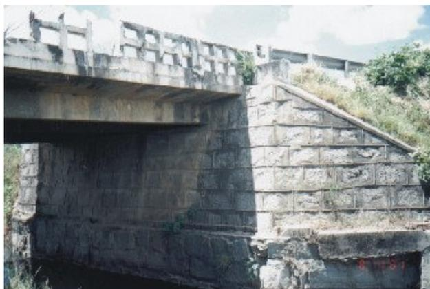
Foto 4.3.5.3 – descalçamento da fundação de encontro, provocado por erosão no leito do rio.
