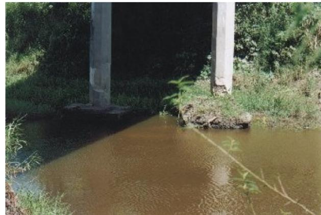
Foto 4.3.5.6 – descalçamento de fundações, provocado pela erosão no leito do rio. Observa-se, também, os pilares danificados com exposição de armaduras em processo de oxidação, devido a desagregação da camada de cobrimento do concreto.
