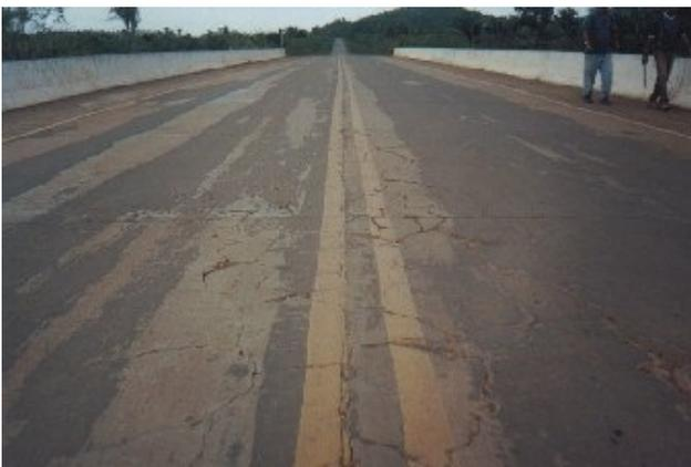
Foto 4.3.7 – **falhas na pavimentação** – as trincas, desgastes e irregularidades no pavimento são geralmente provocadas pelo tráfego de veículos, infiltração de água, retração do concreto, quebra de juntas e desgastes superficiais ou ondulações, no caso de pavimentações asfálticas. Tais deficiências representam riscos imediatos aos usuários e contribuem para a deterioração estrutural do tabuleiro.
