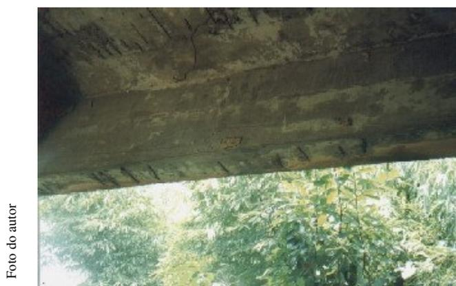
**Foto 4.3.1 – avarias em vigas principais** – exposição de armaduras, especialmente estribos na face inferior. As demais partes da viga não apresentam problemas de cobrimento. Torna-se necessário a realização de reparos para que a integridade da peça não seja comprometida
