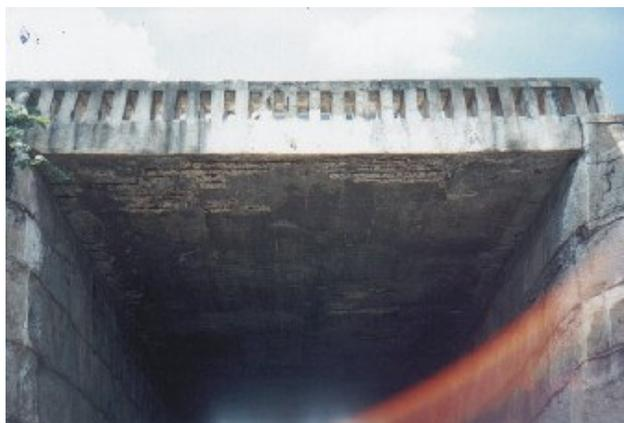
Foto 4.3.5 – **avarias nos estrados em lajes maciças** – ausência de pingadeiras nos bordos, infiltração d’água no tabuleiro, concreto poroso e meio ambiente agressivo podem causar o avançado estado de deterioração, com maior intensidade junto aos bordos da laje.
