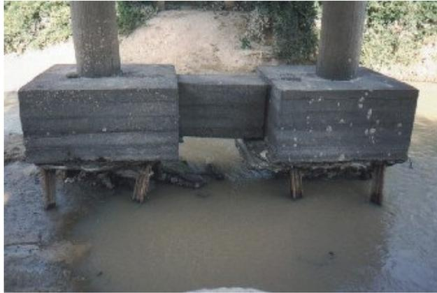
Foto 4.3.5.1 – exposição do trecho superior de estacas metálicas, mostrando a ausência de confinamento lateral. O problema foi causado pela erosão do solo no leito do rio e pode pôr em risco a estabilidade da obra, devido à diminuição da capacidade de carga das estacas.
