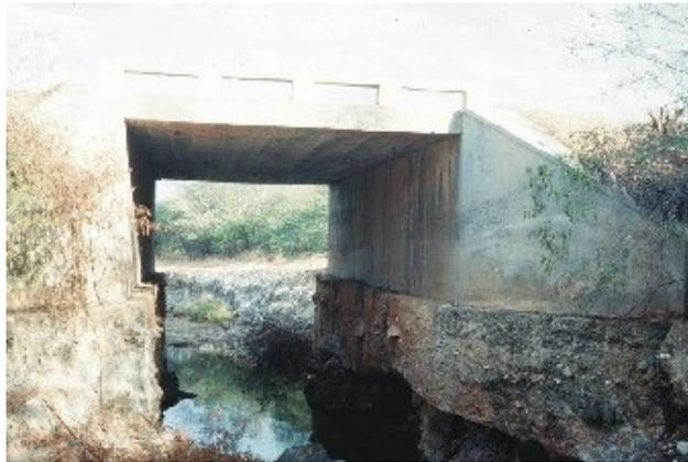
Foto 4.3.5.2 – descalçamento da fundação de encontro provocado pela baixa resistência à erosão da rocha tipo Micaxista.
