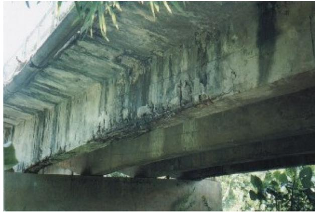
Foto 4.3.2 – **avarias em vigas principais** – estágio muito avançado de deterioração da viga situada em meio ambiente agressivo. A forte corrosão das armaduras expostas e a deterioração do concreto reduziram a resistência à flexão da viga, o que implica nesses casos na necessidade urgente de reparos sob pena do risco iminente à estabilidade da obra.
