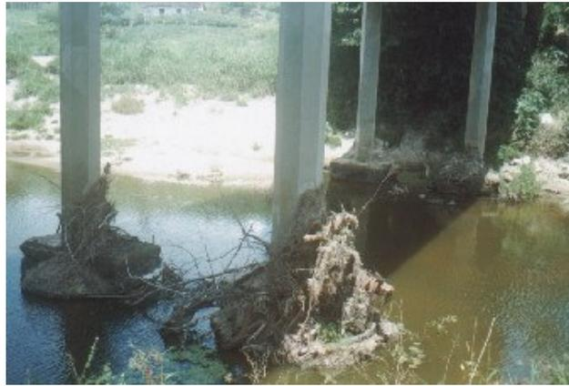
Foto 4.3.5.7 – obstrução da calha do rio, aumentando a intensidade da erosão em torno dos pilares.
