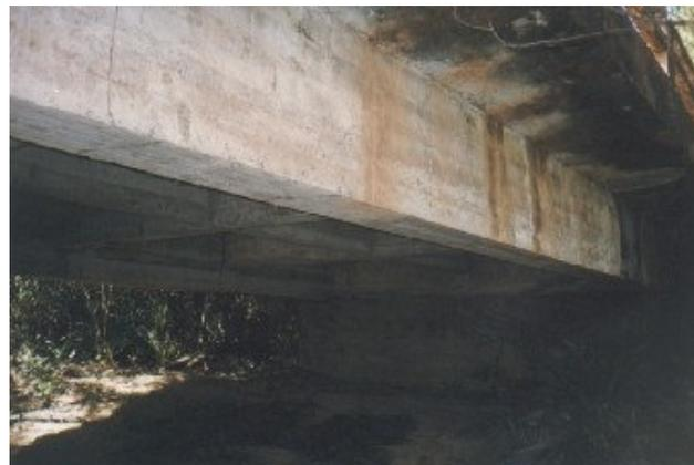
Foto 4.3.4 – **avarias nas lajes em balanço** – as principais causas dos danos às lajes em balanço são a falta de pingadeiras no bordo inferior e a má qualidade do concreto. A constante umidade pode comprometer a integridade da laje ao longo do tempo.
