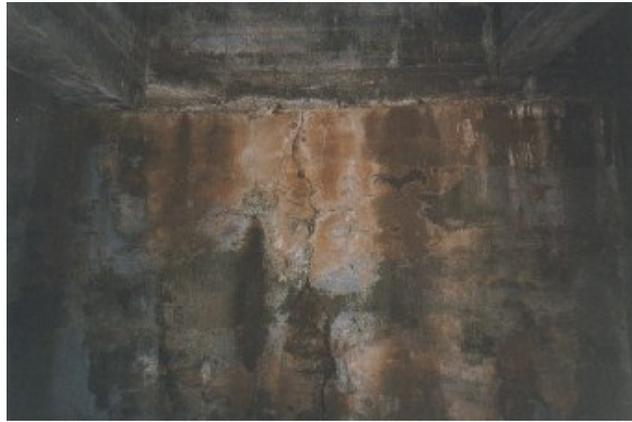
Foto 4.3.5.4 – fissura de tração em encontro de concreto ciclópico. Observa-se, também, forte umidade causada pela infiltração de água através da junta do tabuleiro.
