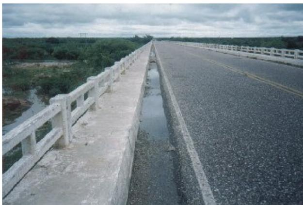
Foto 4.3.8 – **acúmulo de água sobre o tabuleiro** – a obstrução dos drenos e a falta de declividade para escoamento, fazem com que as águas das chuvas acumuladas no tabuleiro se infiltrem e provoquem a deterioração da superestrutura.
