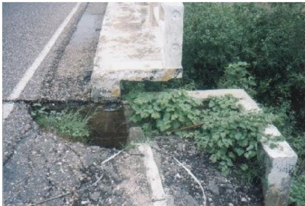
Foto 4.3.5.9 – fuga do material de aterro sob as cortinas separando-o fisicamente do tabuleiro da ponte. Ocorre, ainda, o abatimento entre o maciço e a ponte, agravado pela inexistência de placas de aproximação.
