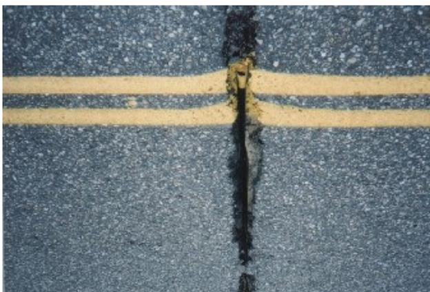
Foto 4.3.6 – **deficiência de juntas de dilatação** – falha de execução, berço de fixação danificado ou inexistente, falta de vedação e abertura excessiva são os principais problemas das juntas de dilatação no tabuleiro, contribuindo para a infiltração de água e suas conseqüências danosas.
