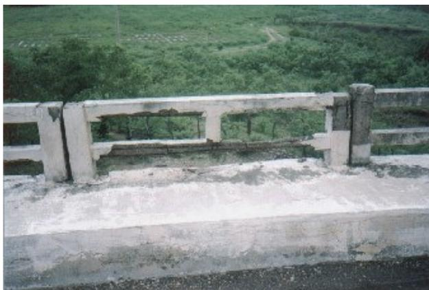
Foto 4.3.9 – **avarias em guarda-corpos** – os principais problemas detectados nos guarda-corpos de concreto nas pontes rodoviárias são concreto de má qualidade, falta de cobrimento das armaduras, ataque de agentes agressivos, ação predatória humana e choque de veículos.
