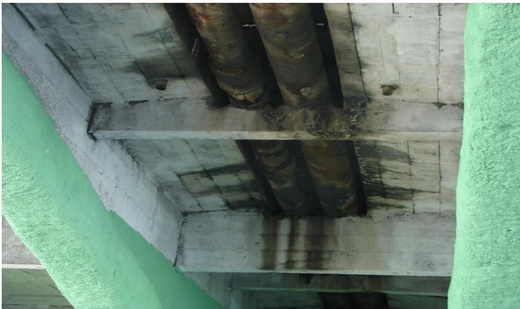
Foto 04 - A situação acima representa um avançado estado de deterioração estrutural do trecho da superestrutura que serve de apoio para as tubulações de ferro. O vazamento da adutora, associado à falta de qualquer manutenção ao longo do tempo já provoca uma situação que implica na necessidade de imediata substituição das tubulações e recuperação da estrutura de concreto do tabuleiro da ponte.
