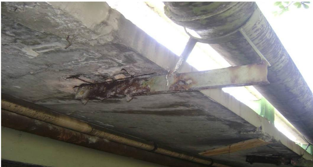
Foto 06 - A tubulação foi apoiada lateralmente ao tabuleiro sobre consoles metálicos fixados na face inferior da laje. A forma inadequada de fixação dos consoles além de causar as patologias indicadas na figura (deterioração, eflorescências, ruptura de armaduras), também implica em risco de ruptura da estrutura metálica de sustentação que apresenta grandes deformações.
