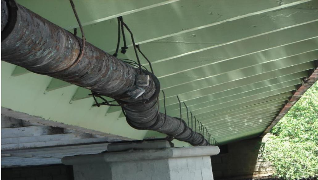
Foto 03 - A foto representa uma situação típica da falta de manutenção de uma tubulação fixada sob o tabuleiro. A ação da atmosfera agressiva oxidou e destruiu parte dos tirantes de sustentação. A tubulação também se encontra oxidada, deformada com risco de ruptura.
