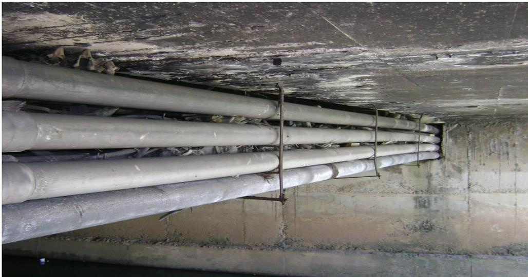
Foto 01 - Detalhe da fixação das tubulações, mostrando abertura feita nos encontros, a oxidação dos tirantes, deformação dos suportes e deterioração do concreto com exposição das armaduras no trecho da laje sobre o "feixe" de tubos. Observar também o estrangulamento da seção do canal causado pelos tubos e a deposição de detritos arrastados pela correnteza.
