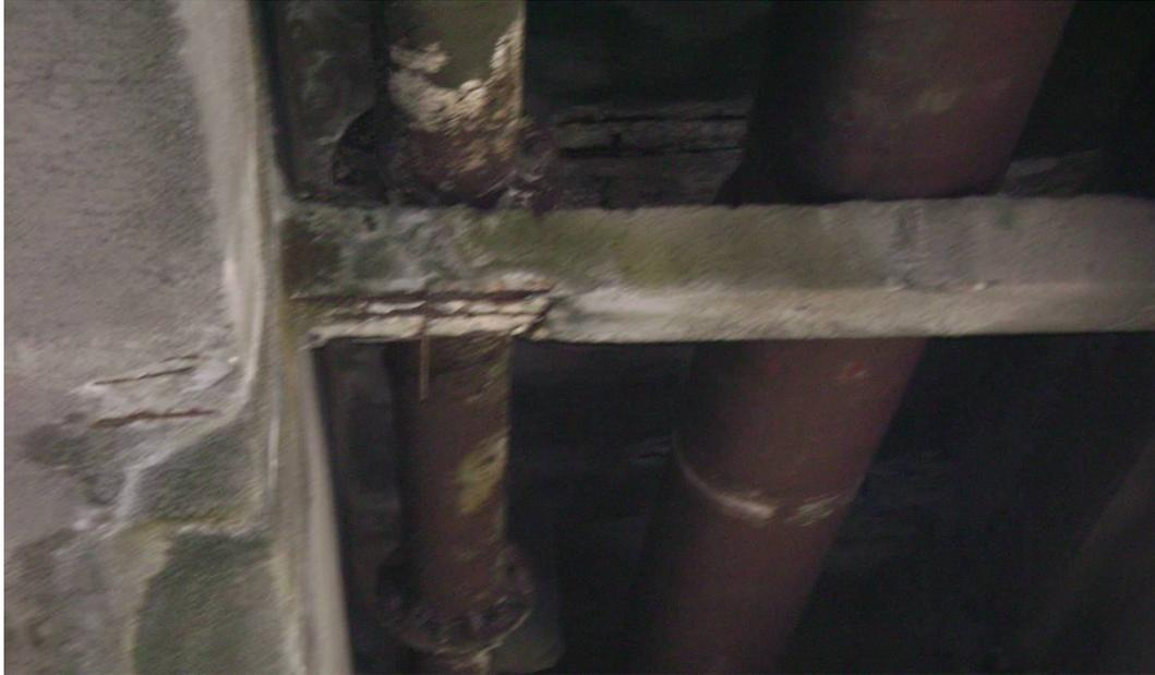
Foto 07 - O suporte de concreto entre as vigas do tabuleiro encontra-se em estado de ruína, devido ao vazamento da tubulação que não apresenta mais condição de operação.
