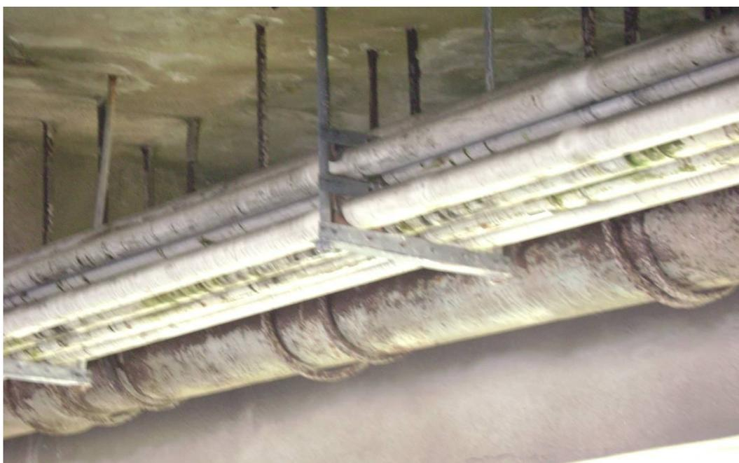
Foto 10 - Situação típica da fixação de diversos tipos de tubulações na face inferior do tabuleiro da ponte. Os furos executados para fixação dos tirantes são pontos vulneráveis para o surgimento de patologias no concreto.
