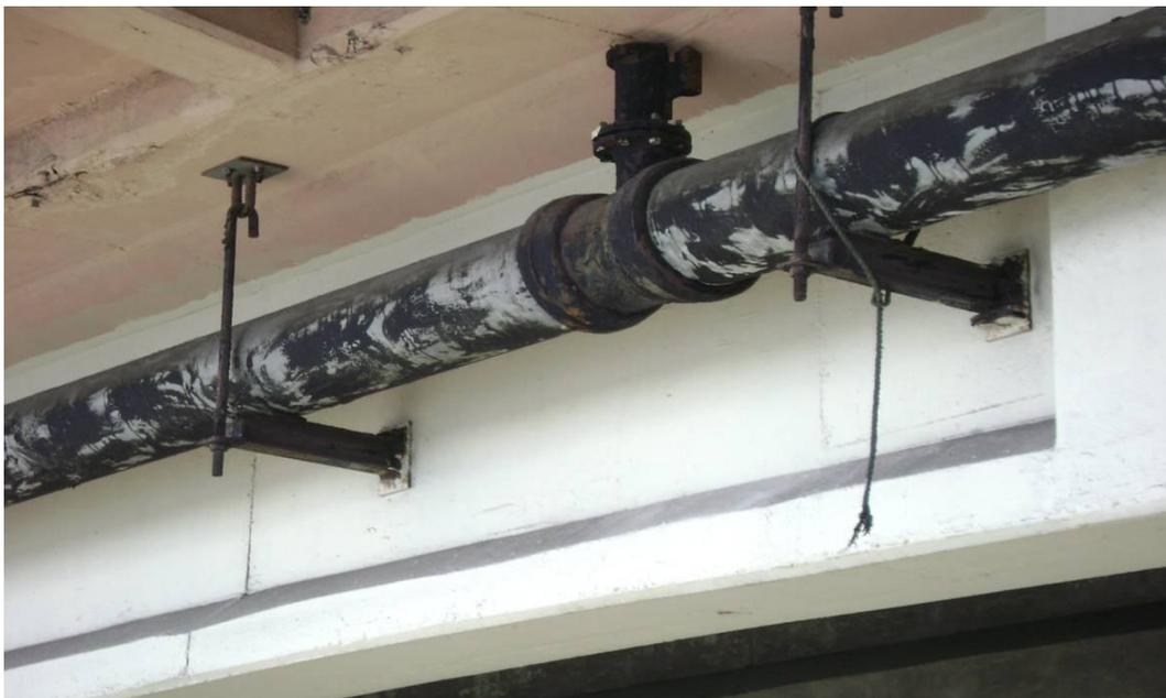
Foto 08 - Situação em que um dos balanços da laje do tabuleiro e uma face lateral da viga principal externa foram totalmente utilizados para a passagem de tubulação. A forma de fixação dos consoles metálicos nas vigas pode ter causado o rompimento de estribos e de armaduras de pele.
