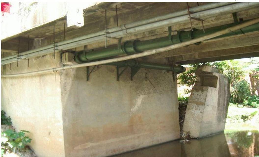
Foto 09 - Uma situação muito comum de fixação inadequada de tubulações, evidenciando-se os danos causados à laje do tabuleiro pelos furos para ancoragem dos tirantes.
