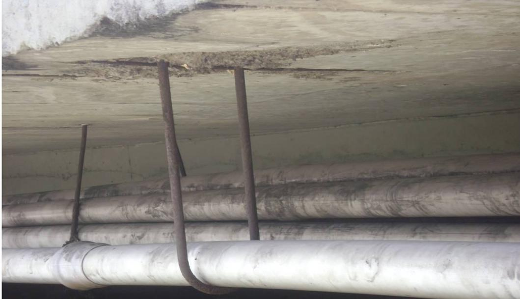
Foto 05 - Uma situação muito comum de fixação inadequada, evidenciando-se os danos causados à laje do tabuleiro pelos furos para ancoragem dos tirantes. Os grandes afastamentos entre os tirantes provocaram a deformação exagerada das tubulações. Observar também a inadequação do tipo de ferro usado para os tirantes.
