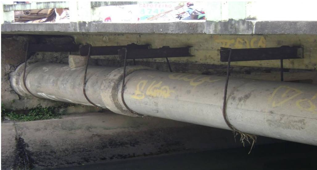
Foto 02 - Forma totalmente imprópria para a sustentação de uma adutora, observando as seguintes incorreções: a) Grande abertura no concreto danificando os encontros; b) Introdução de consolos metálicos danificando e causando torção não prevista no dimensionamento das vigas principais; grande obstrução da calha do canal, aumentando o efeito das cheias.
