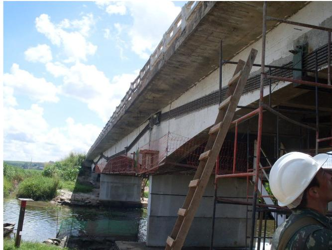
Figura 3 – Reforço das vigas existentes com protensão externa.
