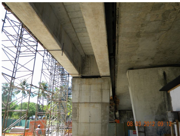
Figura 13 – Vista do tabuleiro após o alargamento.
