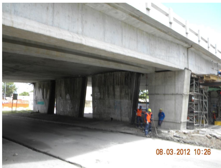
Figura 13 – Vista do tabuleiro após o alargamento.
