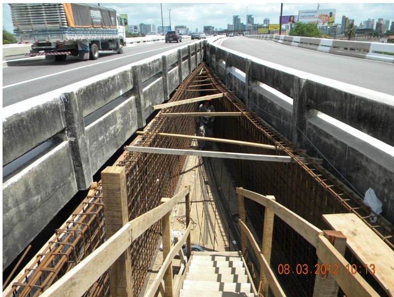
Figura 8 – Detalhe da execução da estrutura no trecho final do alargamento, ligando o novo tabuleiro a duas alças.
