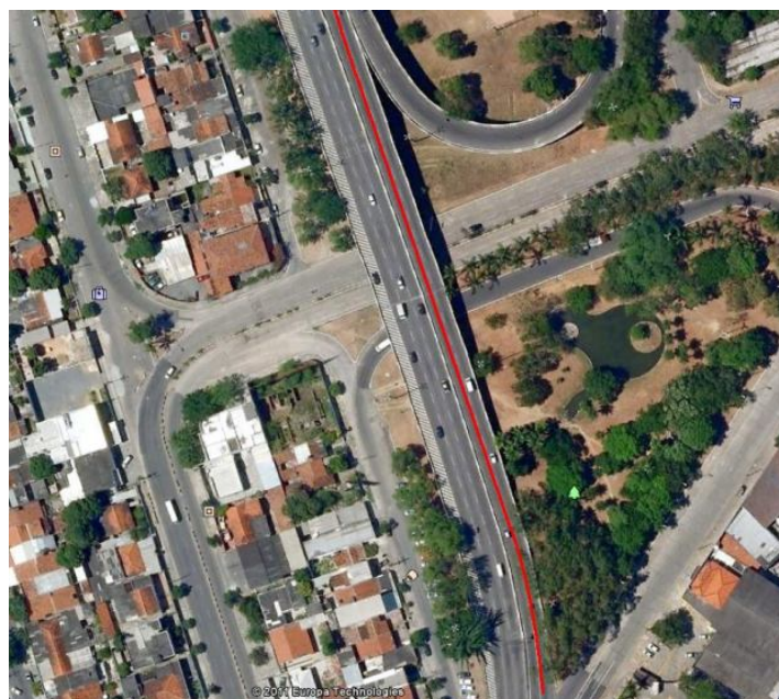
Figura 1 – Vista aérea do viaduto Capitão Temudo.
