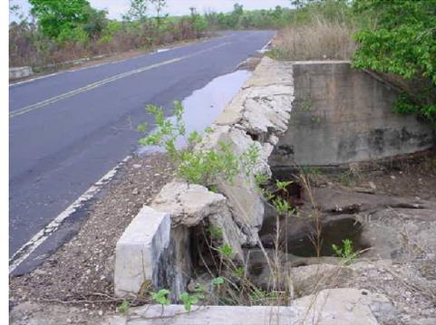
Destruição dos guarda-corpos e empoçamento de água sobre o tabuleiro. (Fonte: VITÓRIO, 2008).
