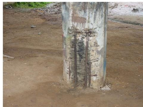
Pilar com dano de grandes intensidades no concreto e nas armaduras (Fonte: VITÓRIO, 2008).
