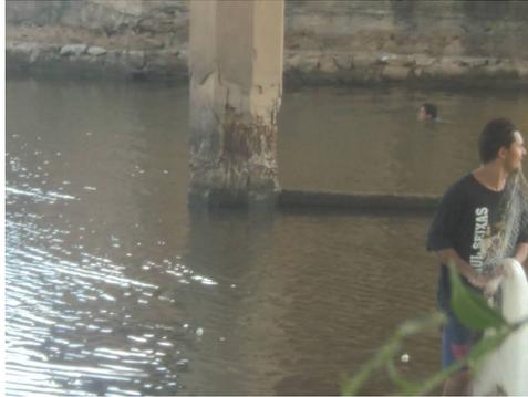
Degradação do concreto e severa corrosão de armaduras de pilar em trecho de variação do nível da água. (Fonte: VITÓRIO, 2010).
