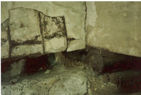
Destruição do concreto, de armaduras e travamento dos aparelhos de apoio. (Fonte: VITÓRIO, 2008).
