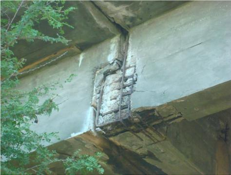
Dente Gerber com avançada degradação do concreto e das armaduras, implicando em risco estrutural (Fonte: VITÓRIO, 2010).
