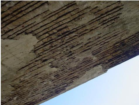
Face inferior de tabuleiro em laje com deslocamento do concreto e corrosão das armaduras. (Fonte: VITÓRIO, 2008).
