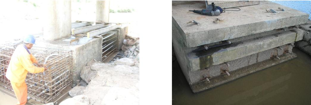
Reforço de fundação com estacas adicionais e ampliação do bloco com aplicação de protensão (Fonte: VITÓRIO, 2012).
