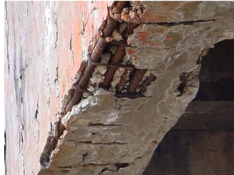
Avançado grau de deterioração do concreto e corrosão das armaduras de vigas principais. (Fonte: VITÓRIO, 2008).
