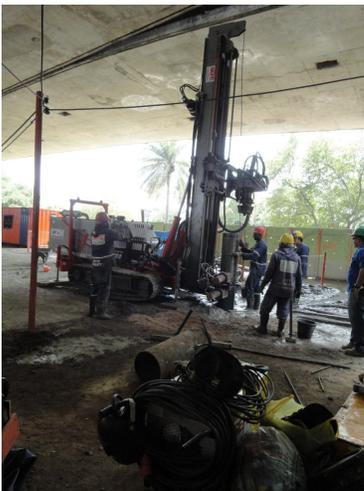
Fundação em estacas raiz sob o tabuleiro existente (Fonte: VITÓRIO, 2012).
