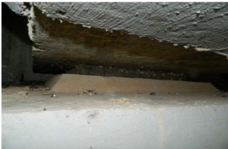
Figura 11. Aparelho de apoio elastomérico com grande excentricidade e deformação
