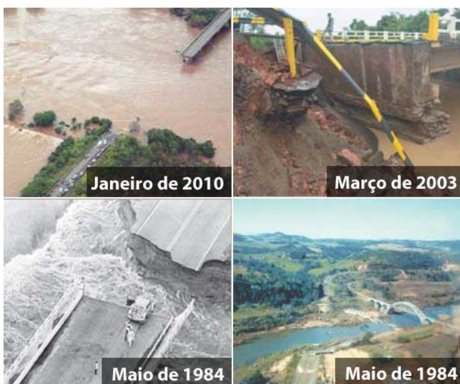
Figura 3.12 - Quatro pontes que sofreram colapso estrutural na rodovia RSC-287. (Fonte: ZERO HORA, 2010)
