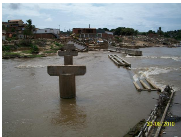
Figura 2.3 - Partes dos tramos isostáticos do tabuleiro após serem arremessados pela grade intensidade da pressão exercida pela correnteza. (Fonte: acervo do autor)
