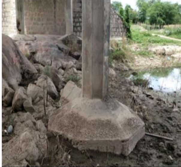
Figura 3.1 - Sapata em condição limite de solapamento. (Fonte: acervo do autor)
