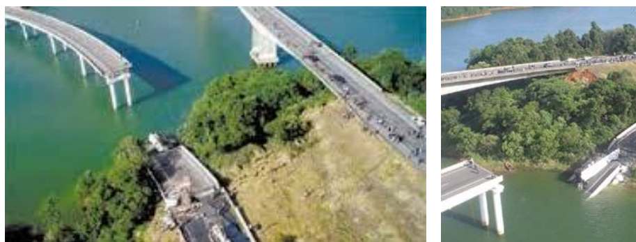
Figura 4.8 - Aspectos do desabamento da ponte sobre a represa do Rio Capivari na BR 116/PR. (Fonte: Internet)
