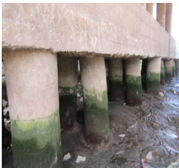
Figura 3.8 - Evolução da erosão em torno de um bloco de estacas. (Fonte: acervo do autor)
