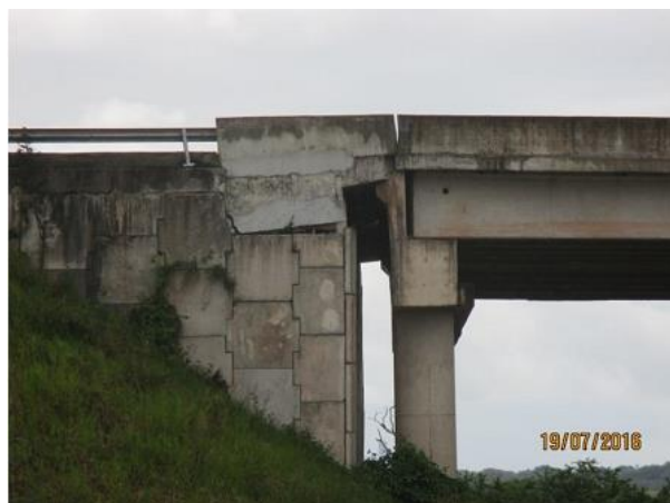
Figura 4.21 - Vista da contenção em terra armada com a rotação da laje de transição causada pela deformação do aterro sobre camada de solo mole. (Fonte: acervo do autor)
