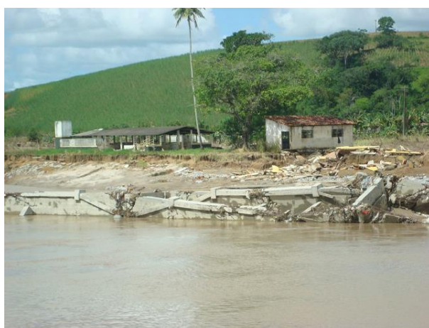
Figura 2.5 - Ruína após o desabamento duplo, podendo ser observado os escombros das longarina de ponte antiga que tinham sido reforçadas com protensão externa. (Fonte: acervo do autor)
