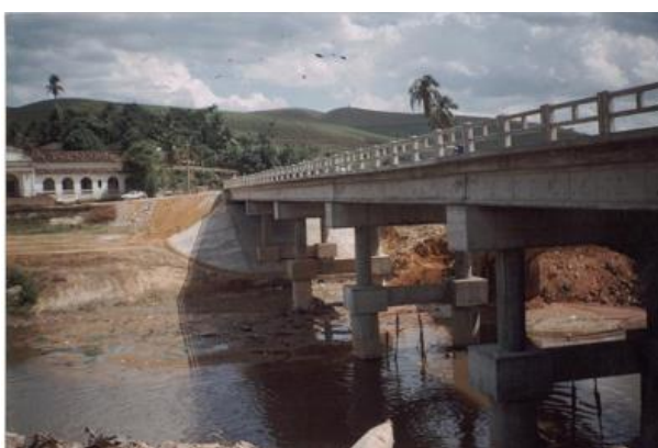
Figura 4.14 - Reconstrução de aterro de acesso protegido por concreto moldado no local. (Fonte: acervo do autor)
