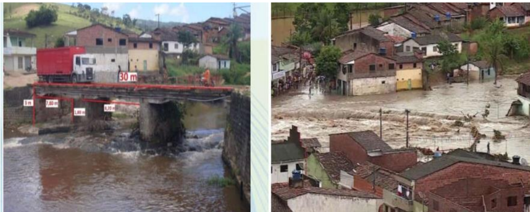
Figura 2.14 - Ponte antes da cheia e depois de totalmente coberta pela água durante a cheia. (Fonte: BURGOS e VITÓRIO, 2017)
