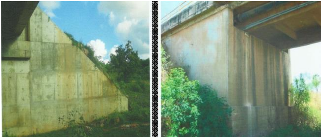
Figura 1.16 - Encontro com alas e encontro com paredes verticais. (Fonte: acervo do autor)
