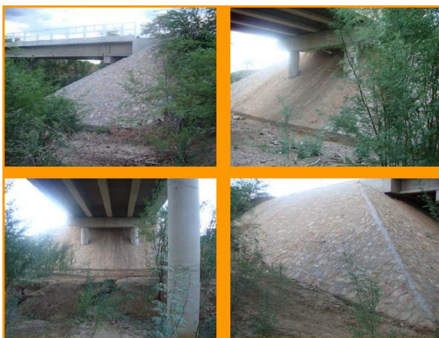
Figura 4.3 - Várias vistas dos taludes dos aterros de acesso de uma ponte rodoviária com extremidades em balanço. Os aterros foram protegidos com alvenaria de pedras argamassadas. (Fonte: acervo do autor)
