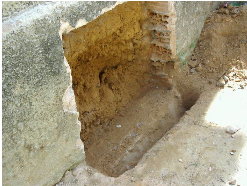
Foto 07 – Retirada de tijolos do embasamento para ensaio e detalhe da fundação em sapata corrida pré-moldada.
