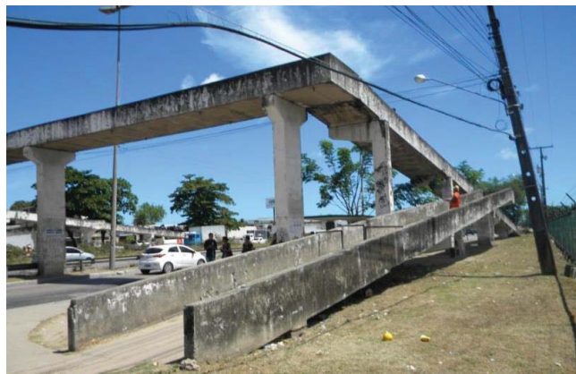
Figura 2 – Vista lateral do trecho em rampa (km 69,2)
