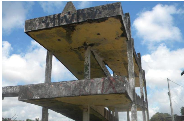
Figura 4 – Vista de um dos trechos em rampa da passarela km 76,9
