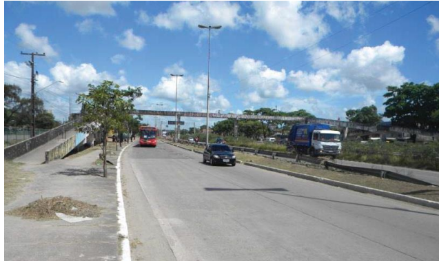
Figura 1 – Vista geral da passarela do km 69,2
