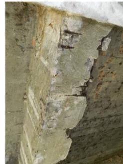
**Figura 11** – Presença de eflorescência em transversina da ponte
